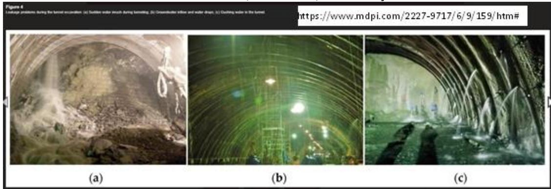
**Figura 18, de túneis com grande afluência de águas subterrâneas vertendo de suas paredes.**
