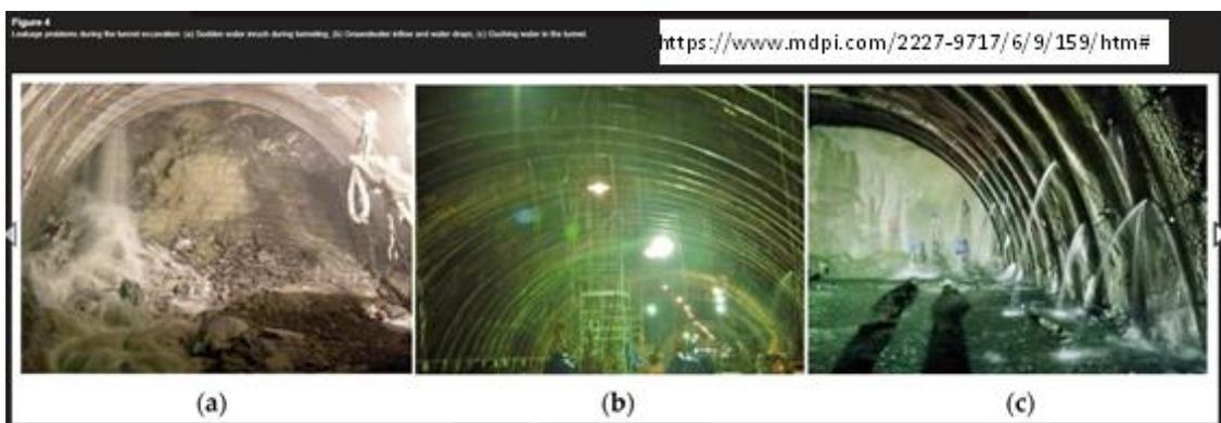
**Figura 18 – Conjunto de fotografias exemplificando o extravasamento de grandes volumes de água subterrânea pelas paredes de túneis escavados em horizontes geológicos formadores de aquíferos relevantes.**
