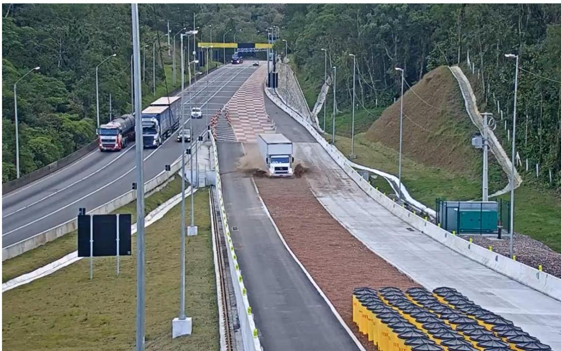
**Fig. 1 – Caminhão sem freios entra em Área de Escape do km 667,3 da BR-376, em Guaratuba/PR. 17 h do dia 25/8/2020**
